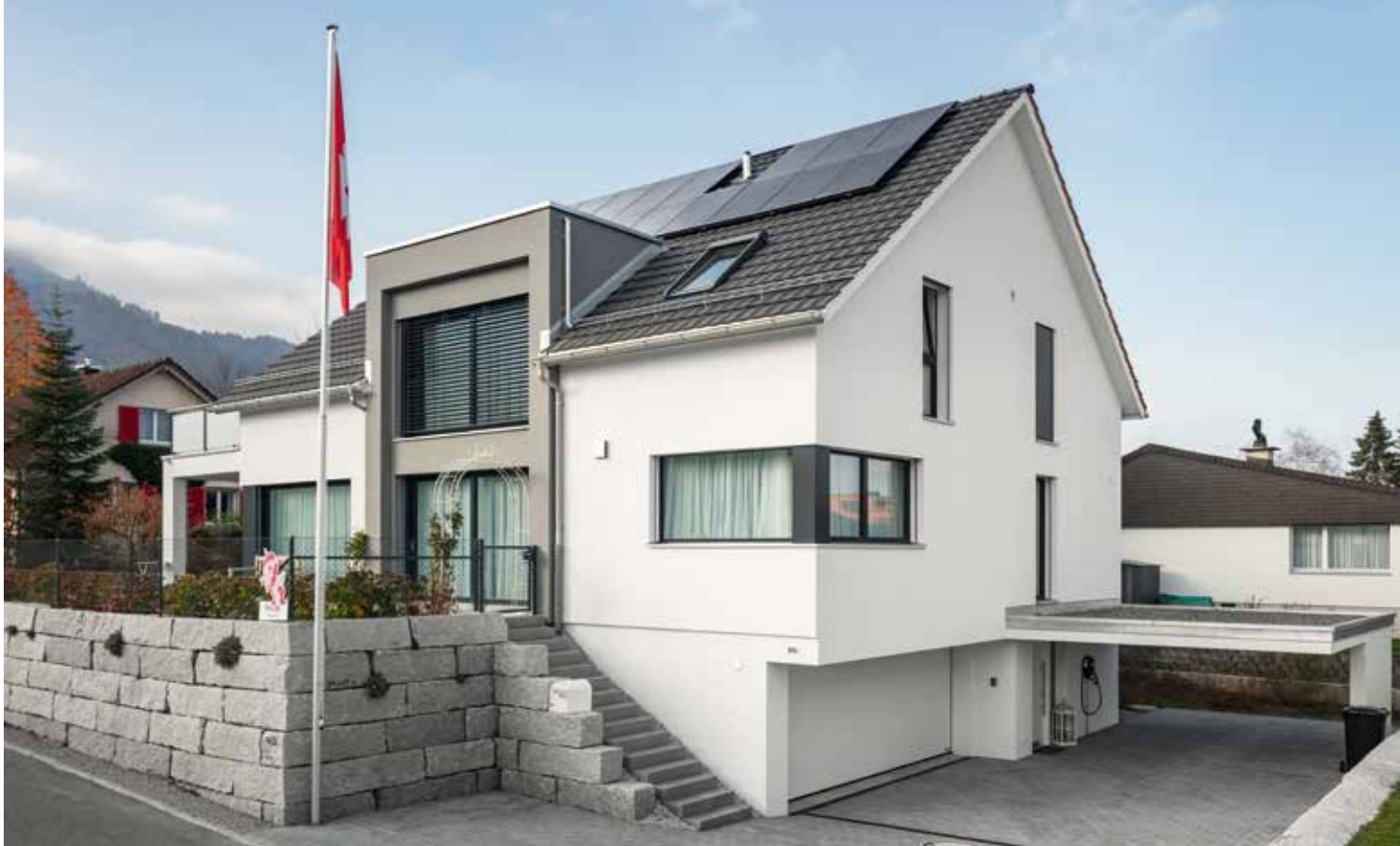
Wärmeversorgung, Photovoltaik, Elektromobilität und smarte Gebäudetechnik: Ein Beispiel, wie das in einem Wohnhaus All-in-One verbunden wurde, ist das Einfamilienhaus von Familie Steiner in Reichenburg im Kanton Schwyz in der Schweiz.
