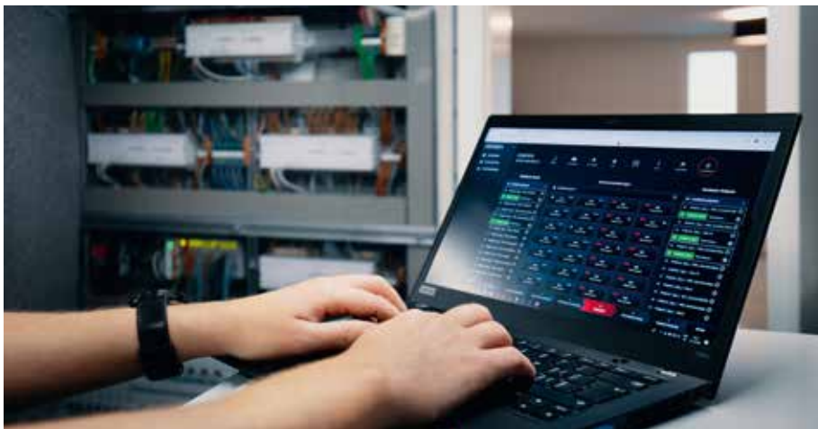
Installateure benötigen keinerlei Programmierkenntnisse, sondern führen die Einstellungen im Setup-Tool auf einer grafischen Oberfläche durch.
